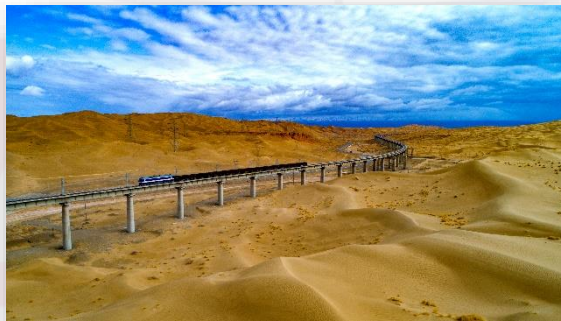
国家优质工程奖—敦格铁路沙山沟特大桥
